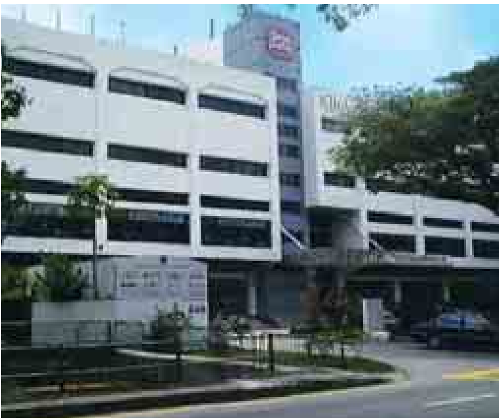
Top Left: Kompleks Sime Darby in UEP Subang Jaya
