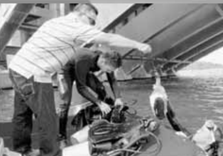
ANGGOKA unit syabas mengambil contoh air bagi mengesan kebocoran dan bersihkan paip di Putrajaya, Putrajaya, semalam.
