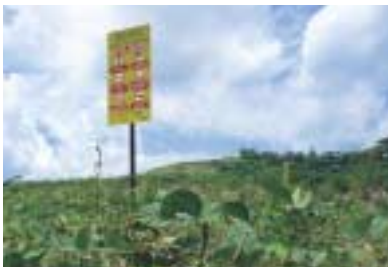
Top/Atas : Safety marker are placed on pipeline right-of-way to indicate the location of the pipelines Penanda keselamatan diletakkan di sepanjang laluan saluran paip untuk menandakan lokasi paip gas
