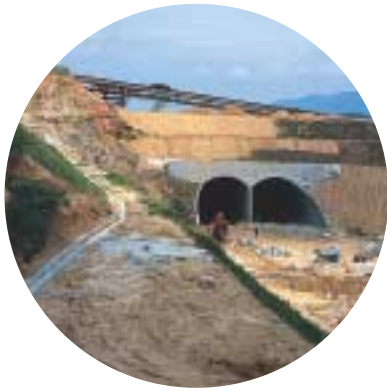
Top/Atas : A tunnel is being constructed below an existing PGU pipeline Terowong sedang dibina di bawah laluan paip PGU yang sedia ada
