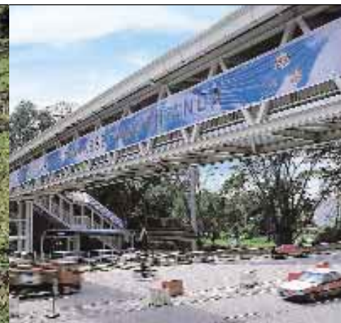
One of 5 pedestrian bridges on Damansara Link Salah satu daripada 5 jejantas di jalan penghubung Damansara
