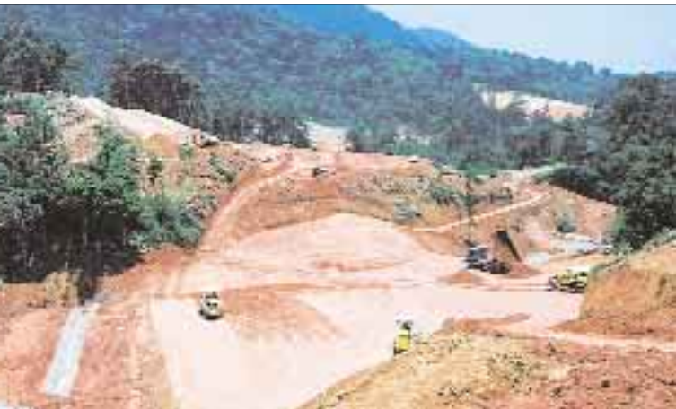
Construction works progressing smoothly at SSP3 Kerja pembinaan di SSP3 sedang berjalan lancar
