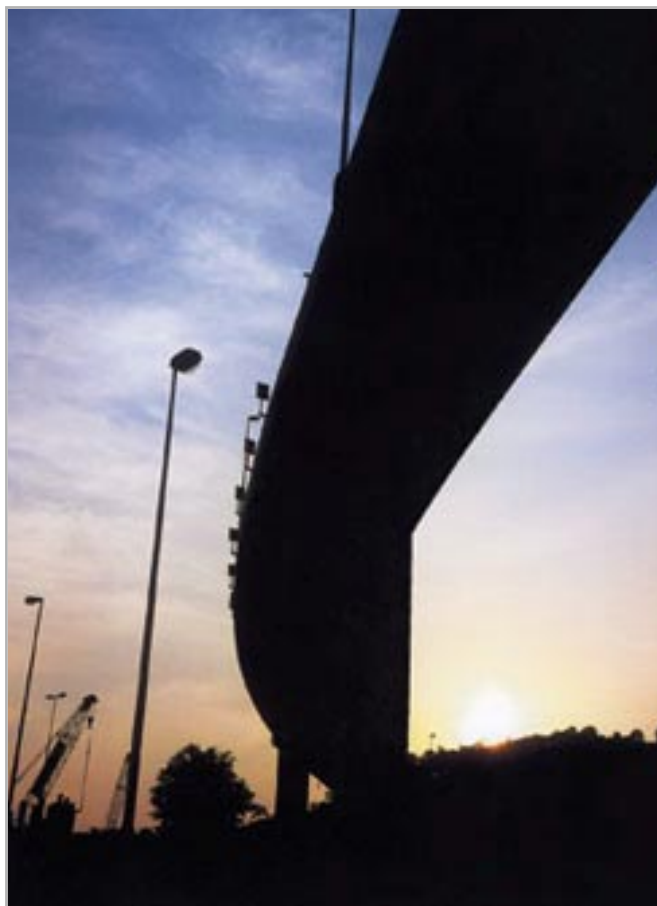
Engineering and construction continues to be the major driver of the group's business. Pictured here is a section of Penchala Link. Kejuruteraan dan pembinaan adalah pendorong utama perniagaan kumpulan. Gambar di atas menunjukkan sebahagian daripada Hubungan Penchala.
