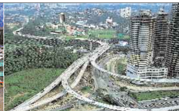
Lebuhraya SPRINT, Kerinchi Interchange Persimpangan bertingkat Kerinchi, Lebuhraya SPRINT
