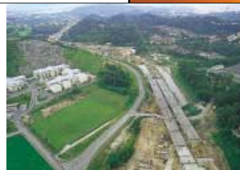
Construction of Kiara Interchange. Pembinaan Persimpangan Bertingkat Kiara.
